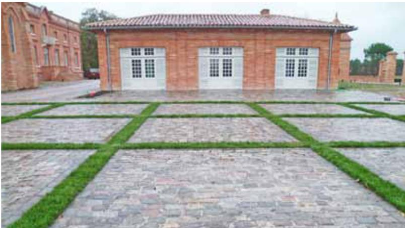
Drainagestreifen, mit dekorativer Funktion, bei denen die Modularität der ECORASTER®-Gitterplatten genutzt wird.
