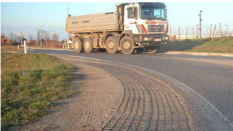
Bankettbefestigungen und Seitenstreifen sind aufgrund der hohen Belastung und Stabilität der ECORASTER®-Gitterplatten kein Problem.
